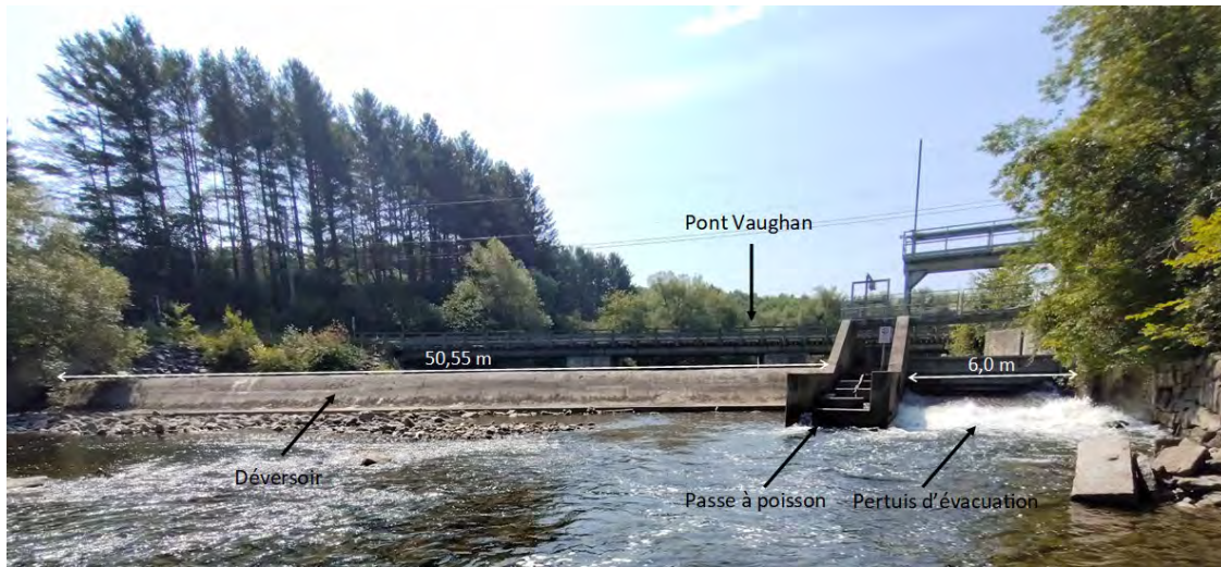
Figure 2-4 : Vue aval du barrage de North Hatley
