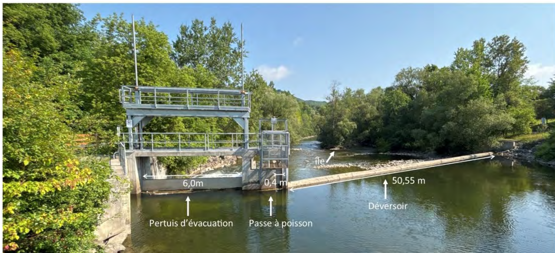
Figure 2-3 : Vue amont du barrage de North Hatley
