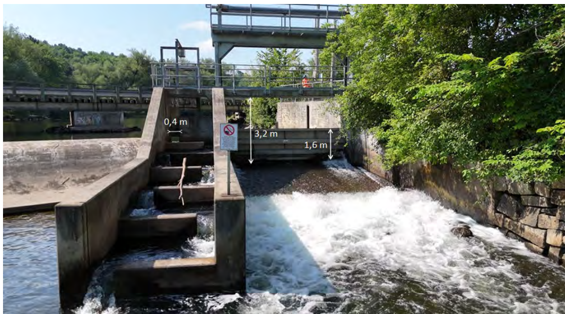
Figure 2-5 : Vue aval du pertuis d'évacuation et de la passe à poisson
